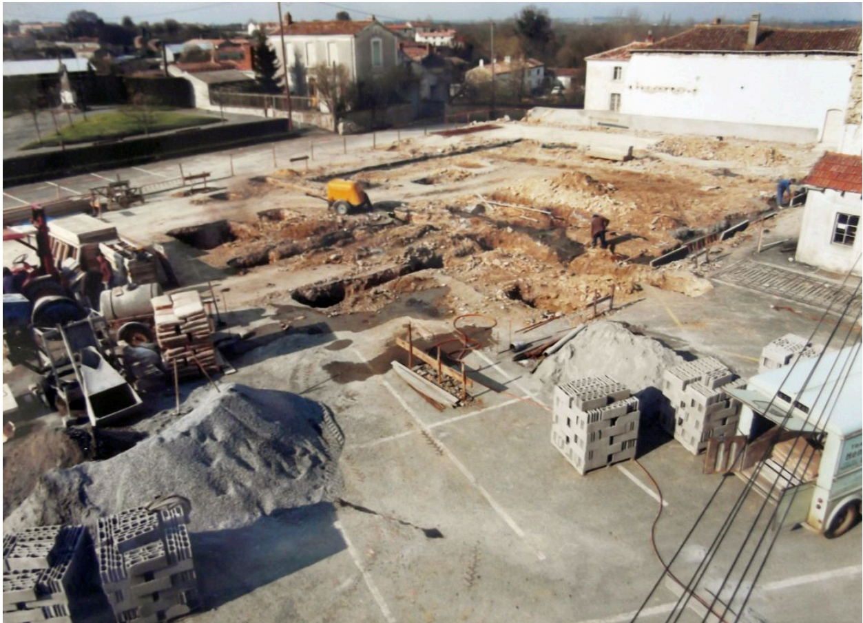
Début de la construction de l'église, mi-février 1974.
