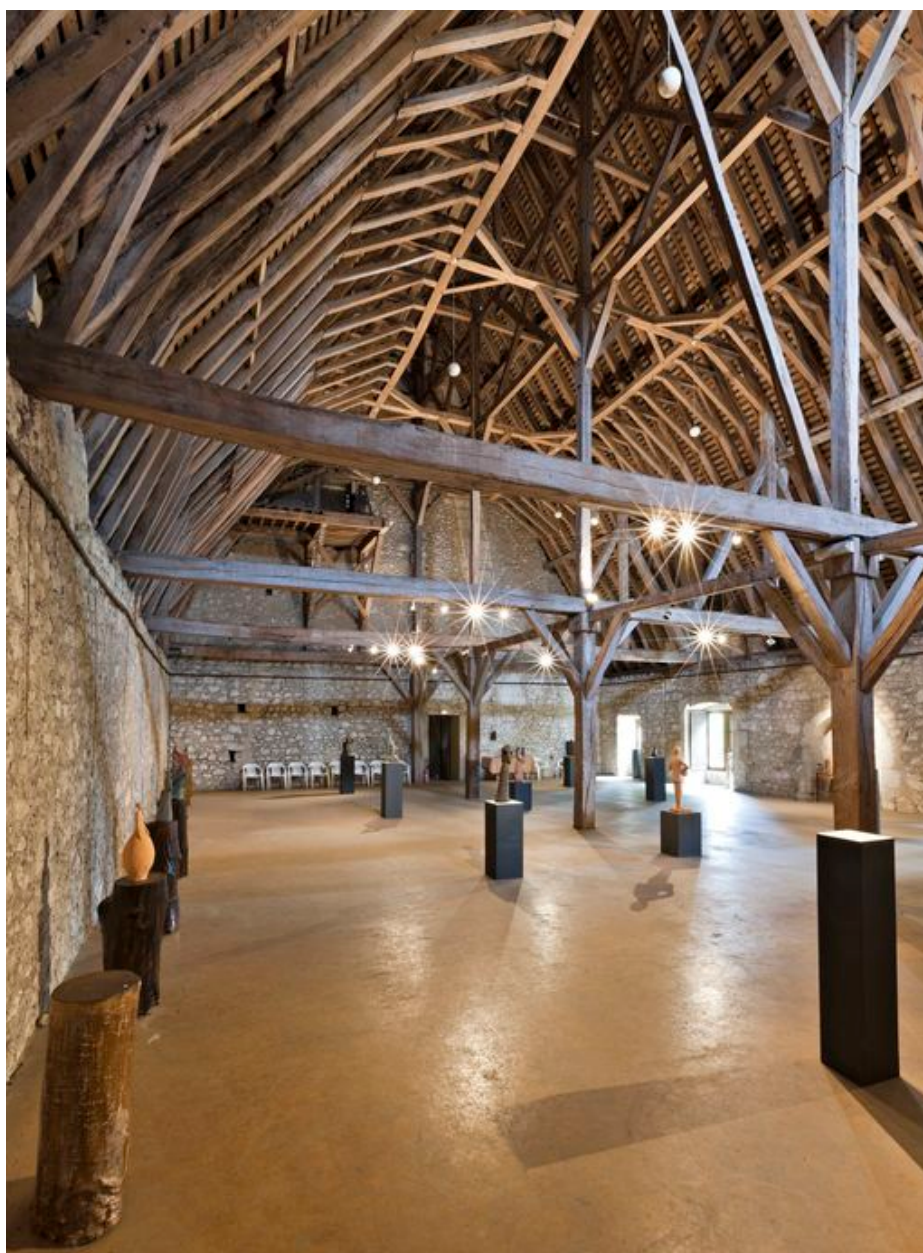
Les greniers à blé : vue d'ensemble de la charpente.
