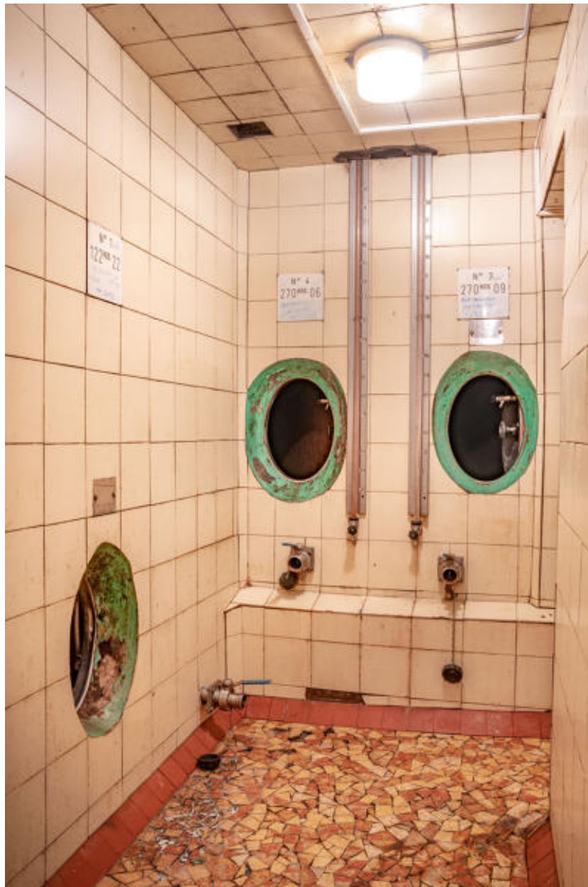
Couloir de service : accès aux cuves enterrées nord-est.
