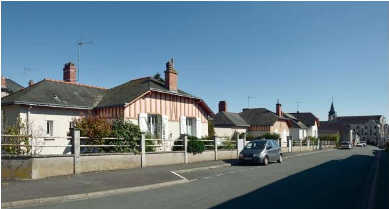
10, 12-14 rue de Bel-Air. Vue d'ensemble depuis le nord-ouest.
