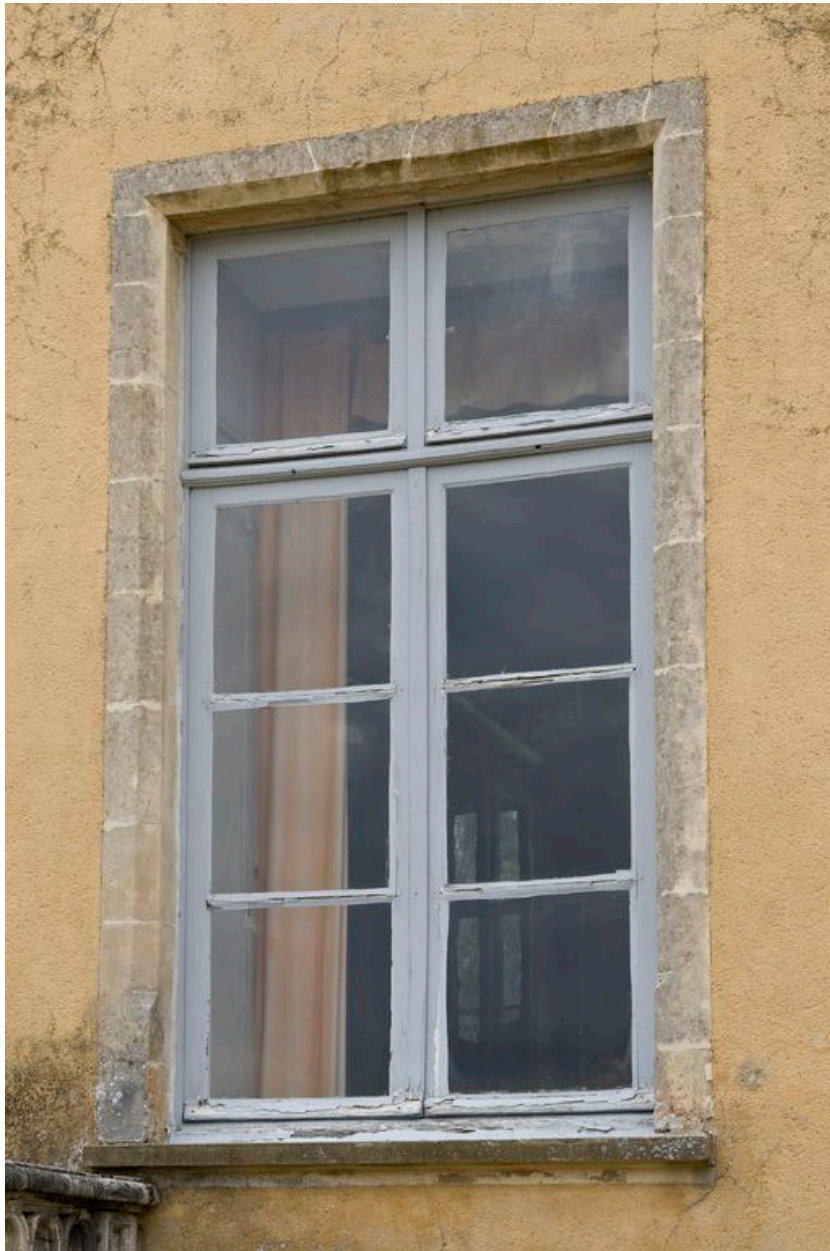
Fenêtre de l'élévation sud du corps central.
