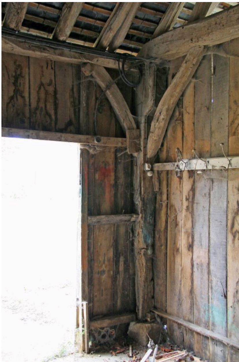
Le hangar sur poteaux de bois.
