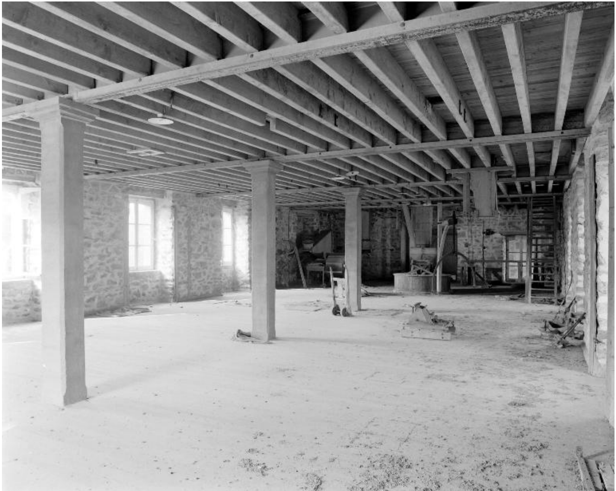
Le premier étage du moulin. Vue vers l'ouest.
