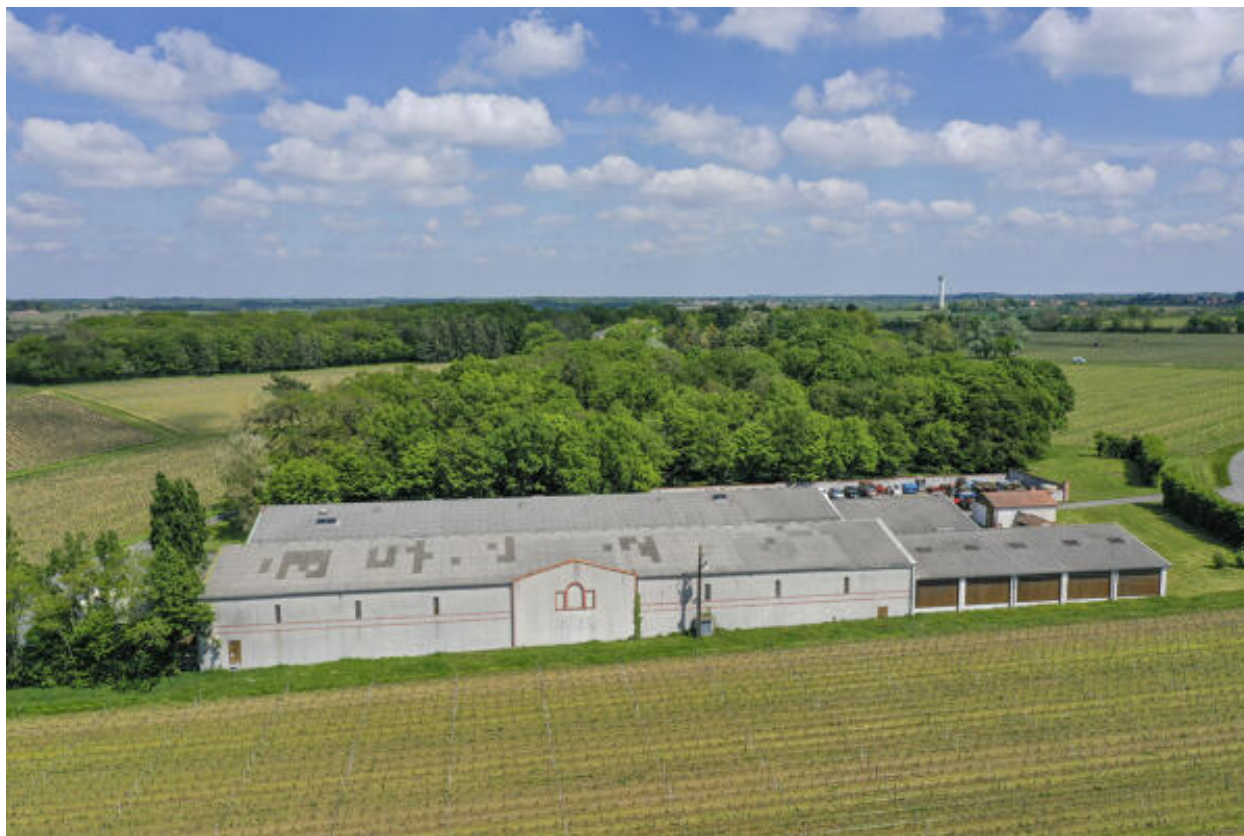
Magasin à vin, vue générale.
