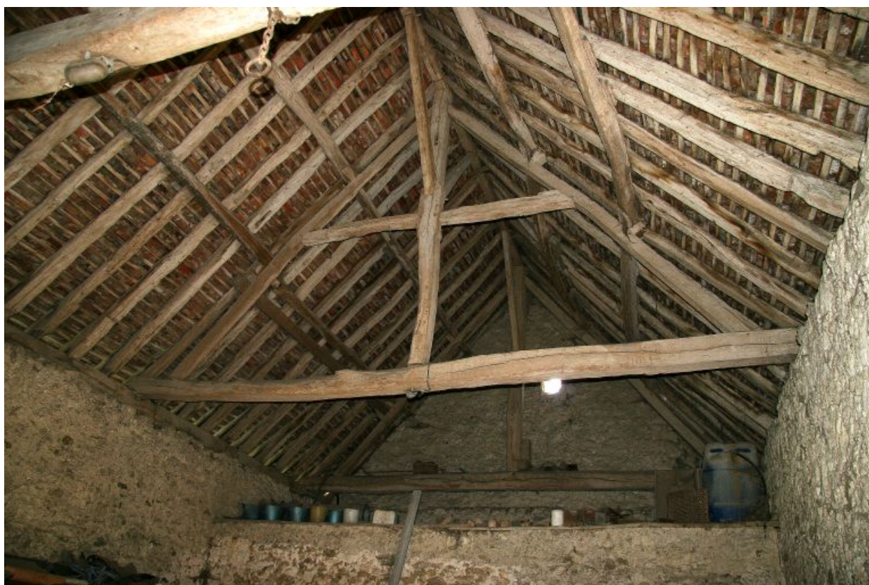
La grange : charpente à pannes.
