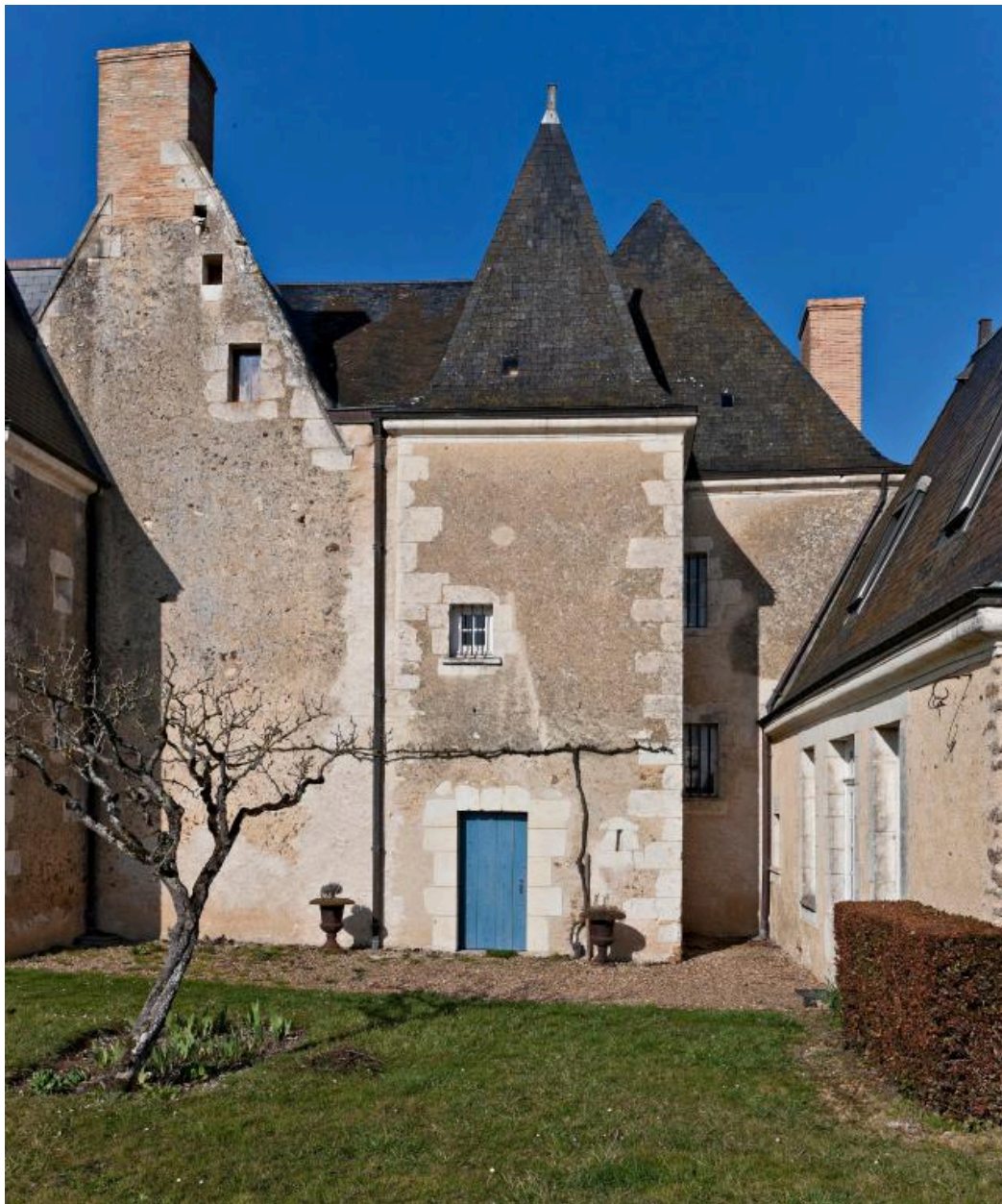
Corps principal, pavillon d'escalier, gros corps central et aile nord-est, vus depuis l'est.
