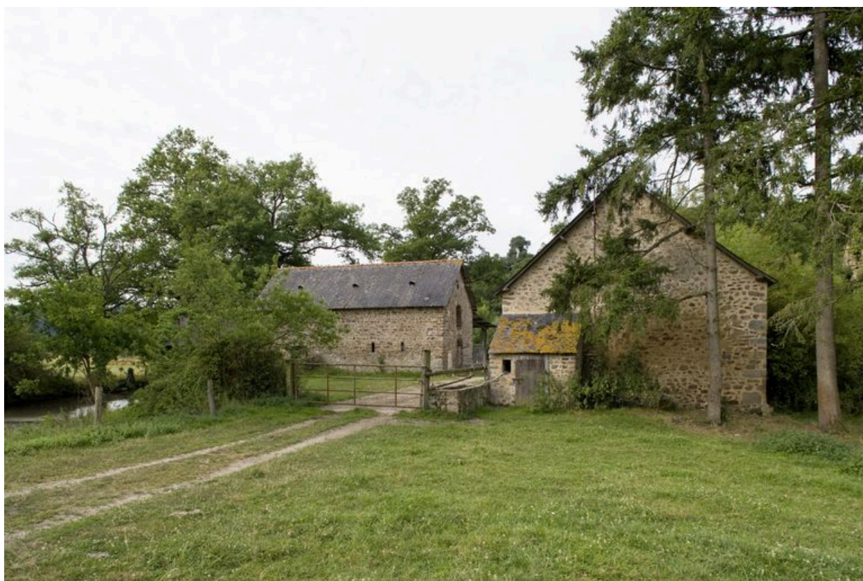
Etable et étable-grange édifiées sur l'ancienne motte : vue d'ensemble depuis le nord.
