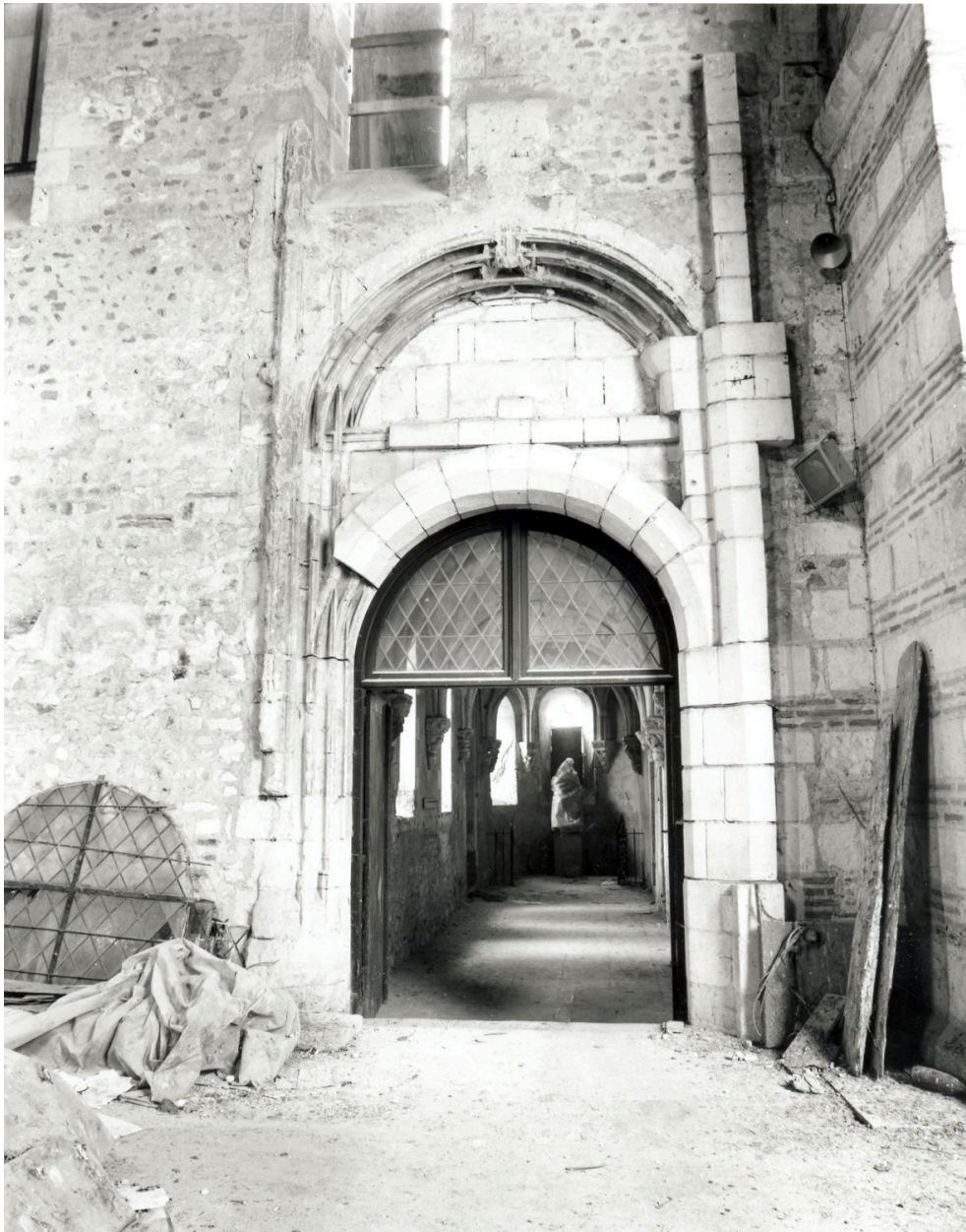
Collégiale Saint-Martin, croisillon nord du transept : porte d'accès à la chapelle des Anges.
