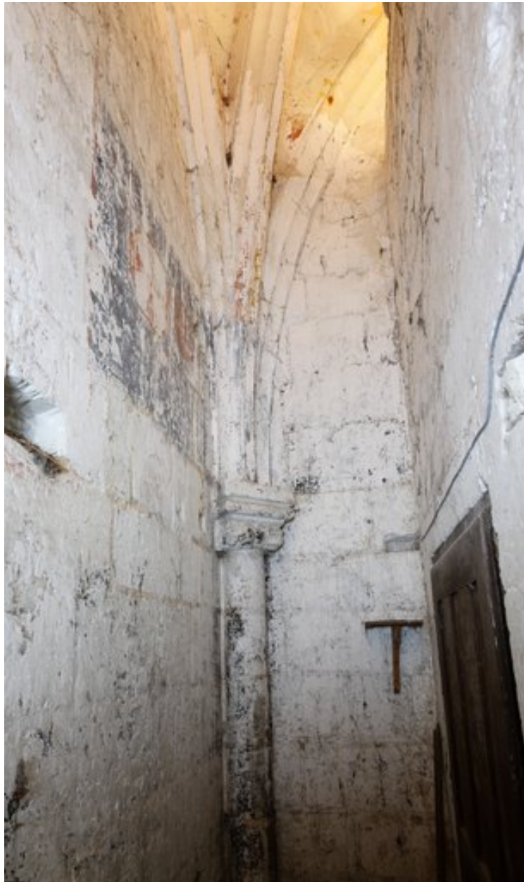
Choeur (derrière le retable), mur est, côté sud : vue d'ensemble du décor peint.
