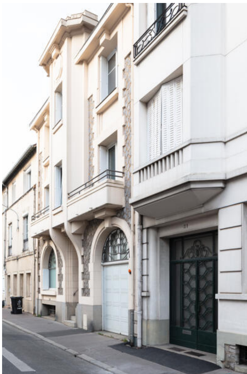
Vue de l'alignement en rez-de-chaussée.
