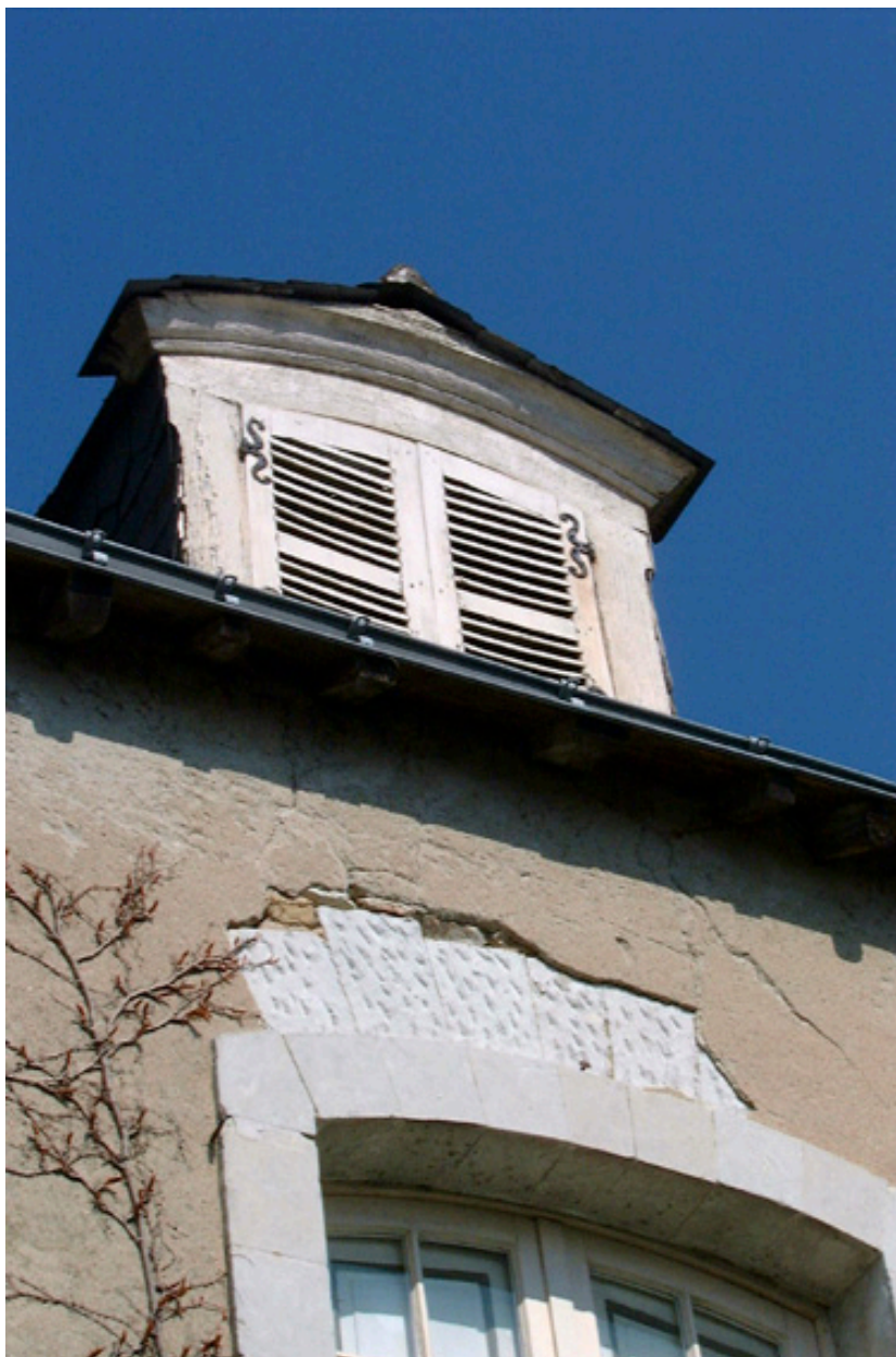
Façade principale : détail d'une lucarne.
