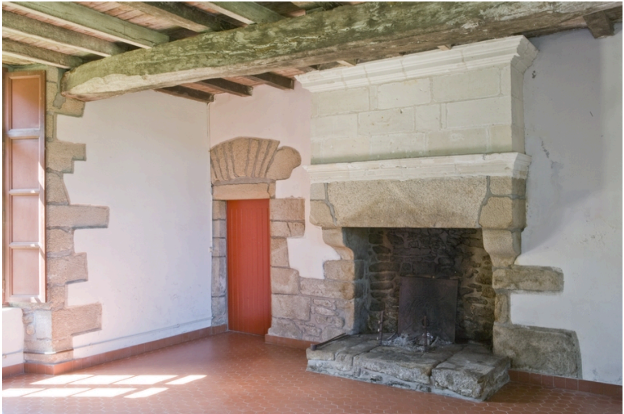
Pavillon. Rez-de-chaussée. Salle sud.
