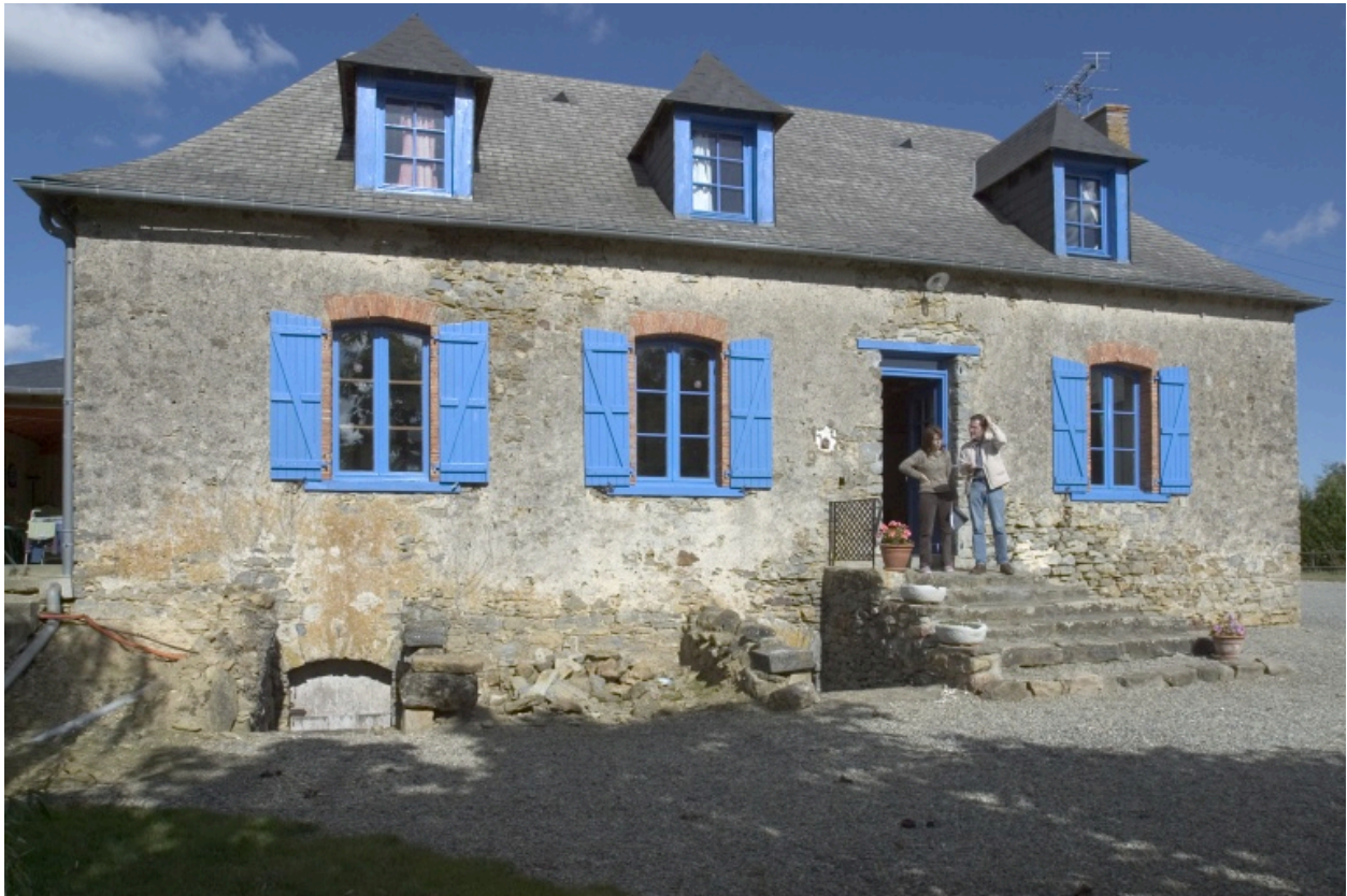
Le logis vu depuis le sud-ouest.
