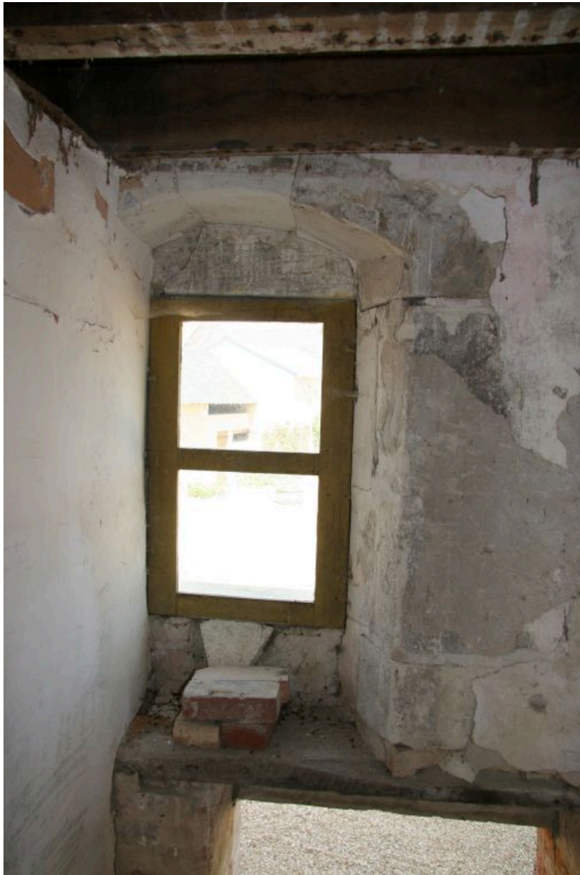
Le logis, escalier dans oeuvre : baie sur la cour.
