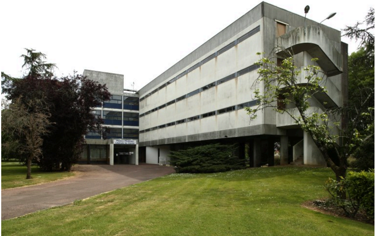
Vue prise du nord-ouest.
