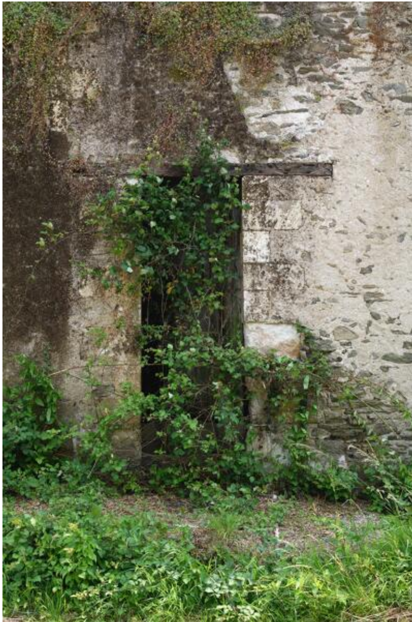
Détail d'une ouverture de logis en pierre de taille de tuffeau avec lindeau en bois.
