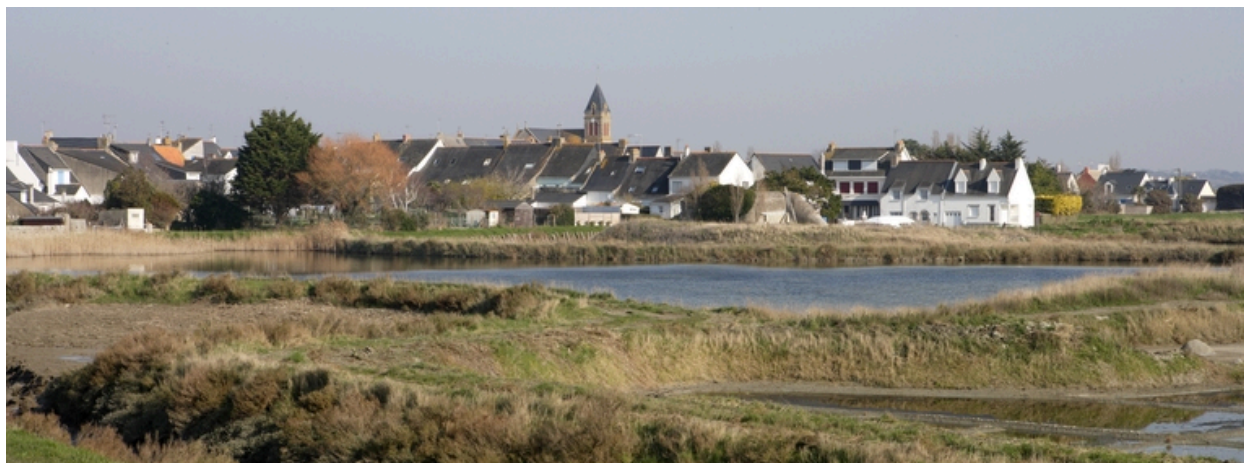
Vue panoramique depuis le sud.
