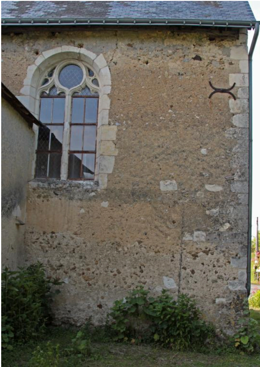
Façade sud du chœur : baie en plein cintre.
