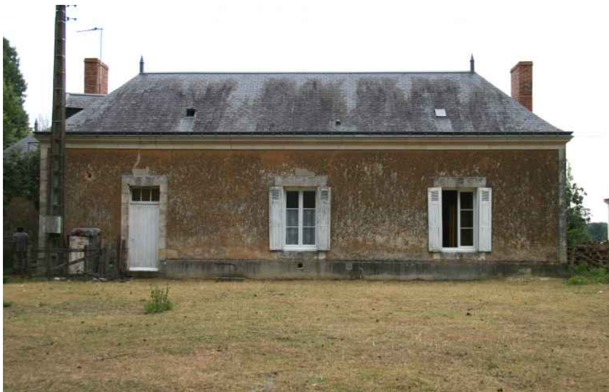
La maison d'habitation de la ferme : façade postérieure.
