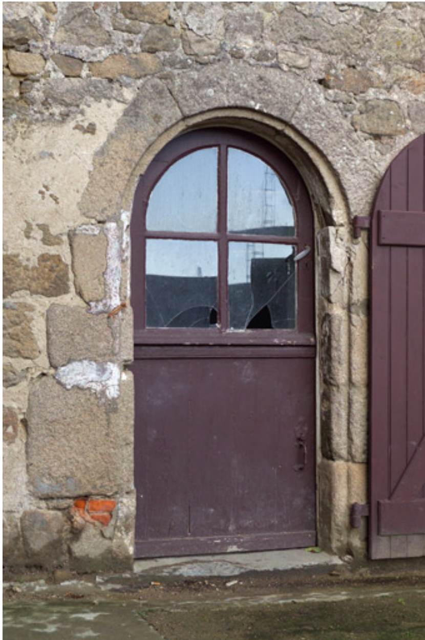
Corps central, façade orientale, détail de la portion sud.
