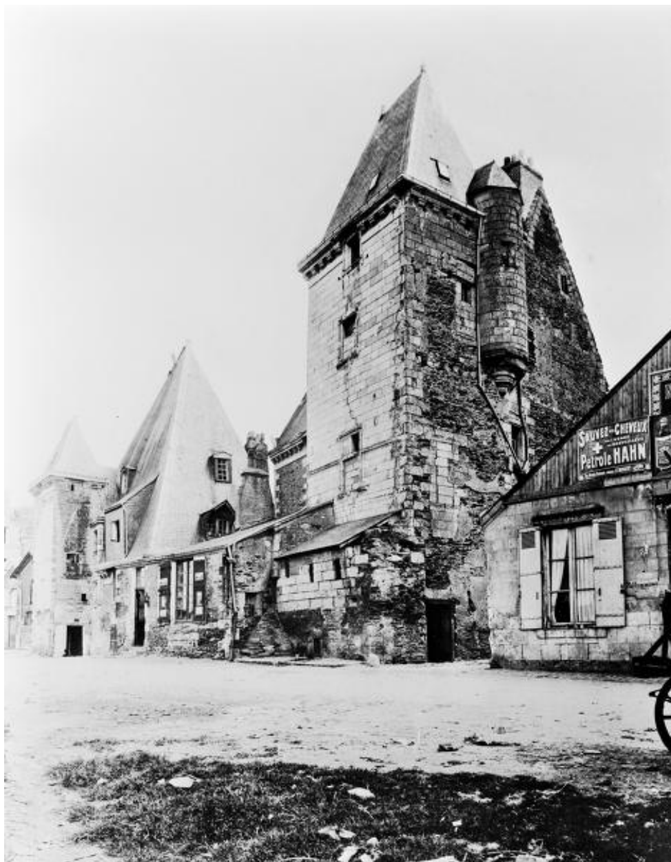
Vue d'ensemble depuis la droite, côté Maine, photographie, avant 1913. (Musées d'Angers ; VII R 82, inv. Labalte 586/1).
