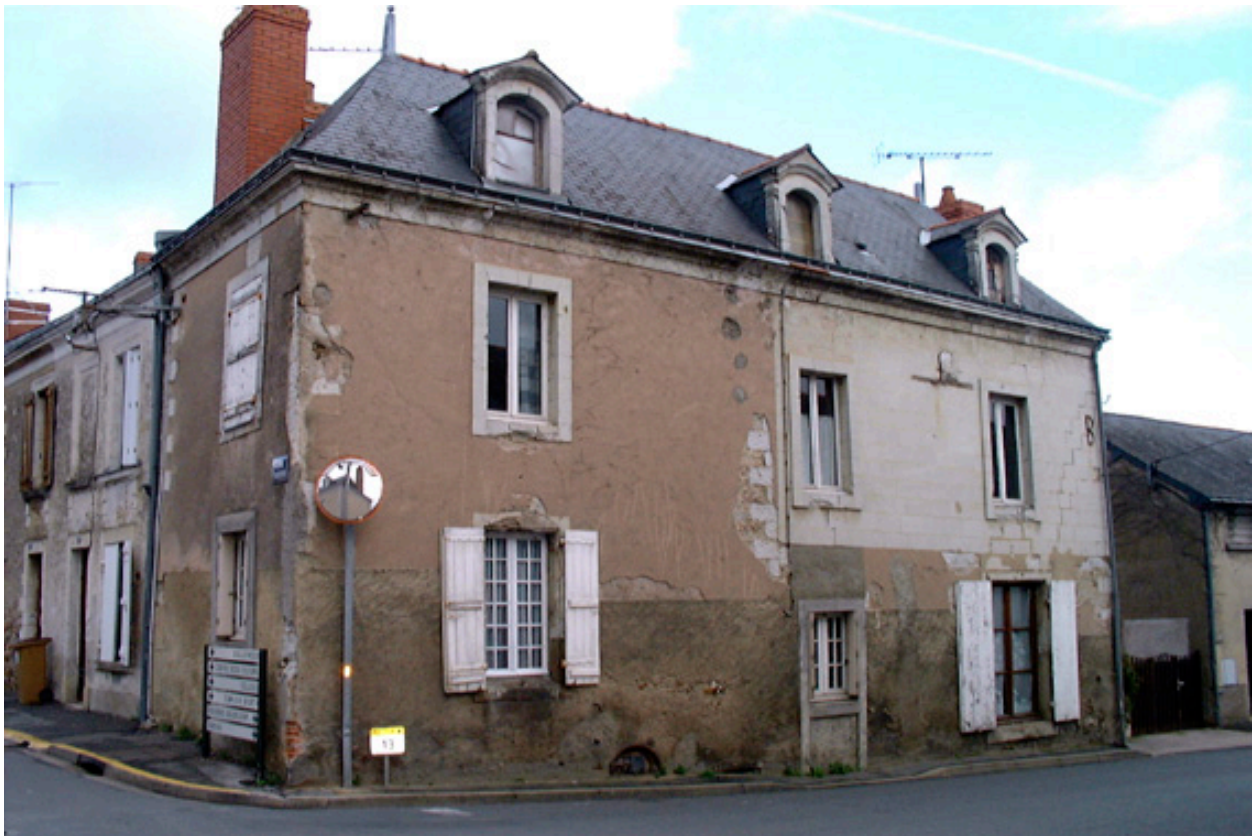
Maison. 18e siècle. Remaniée au 19e siècle.
