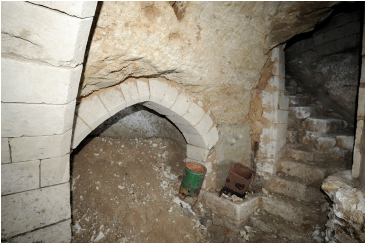
Second sous-sol, entrée de la cave latérale sud (à gauche) : arc brisé chanfreiné.
