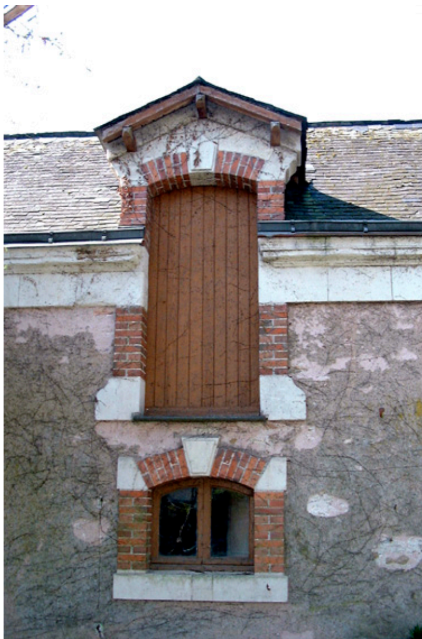
Porte haute avec encadrements en brique et tuffeau.
