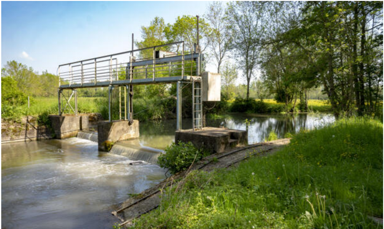
Le barrage de la Vieille Sèvre vu depuis le sud, en aval.
