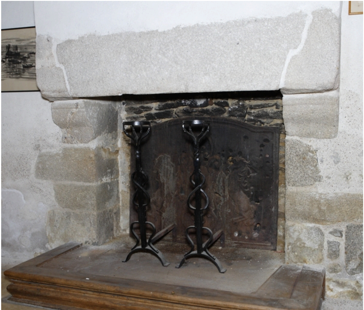
Logis. Rez-de-chaussée. Mur de refend est. Détail de la cheminée.
