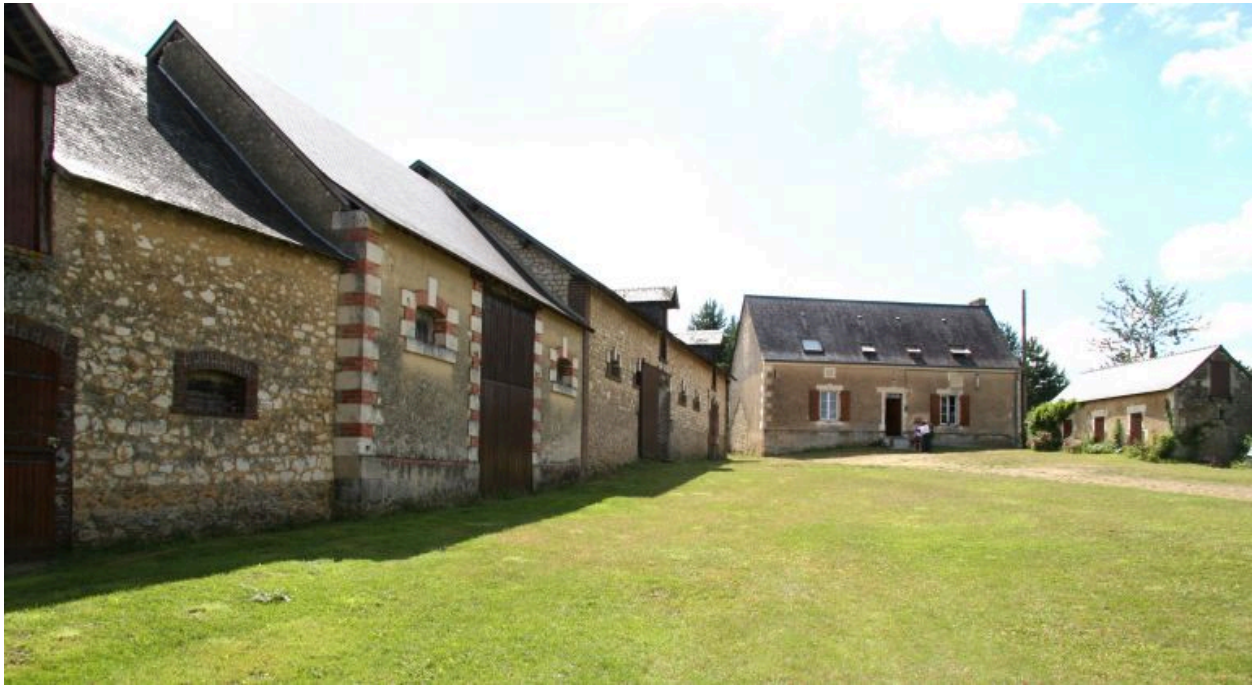
Vue d'ensemble de la maison et des dépendances.
