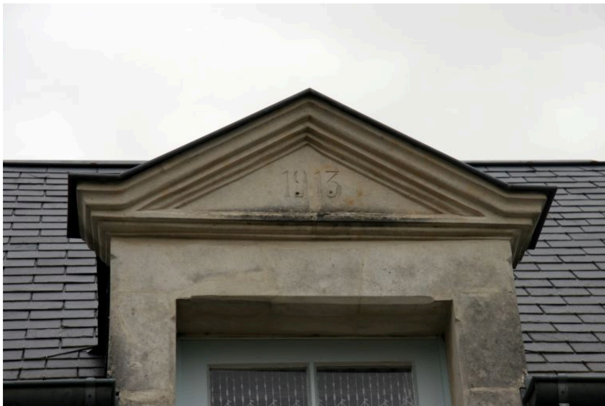
39, rue Principale : lucarne portant la date de 1913.
