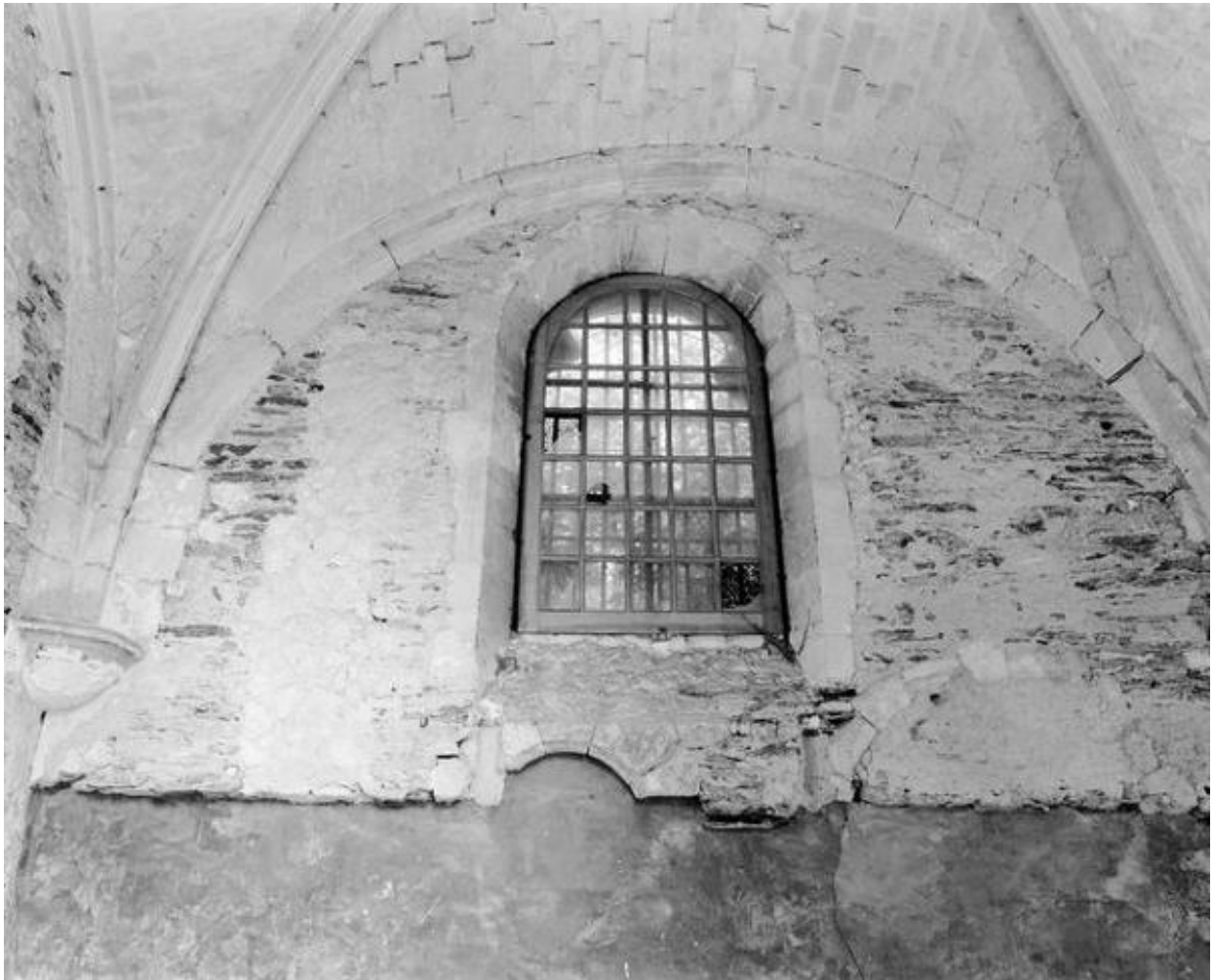
Vestiges de l'église. Chapelle de la Passion, deuxième travée, détail de l'élévation intérieure ouest : vestiges d'arcs non identifiés (liés à des tombeaux ?).
