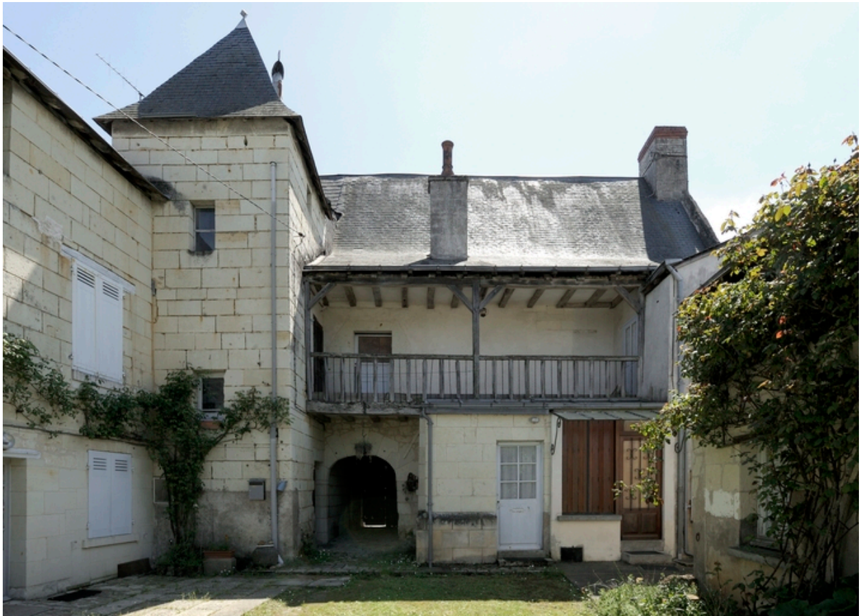
Façade postérieure, sur cour, avec tourelle d'escalier et galerie en charpente de distribution extérieure.
