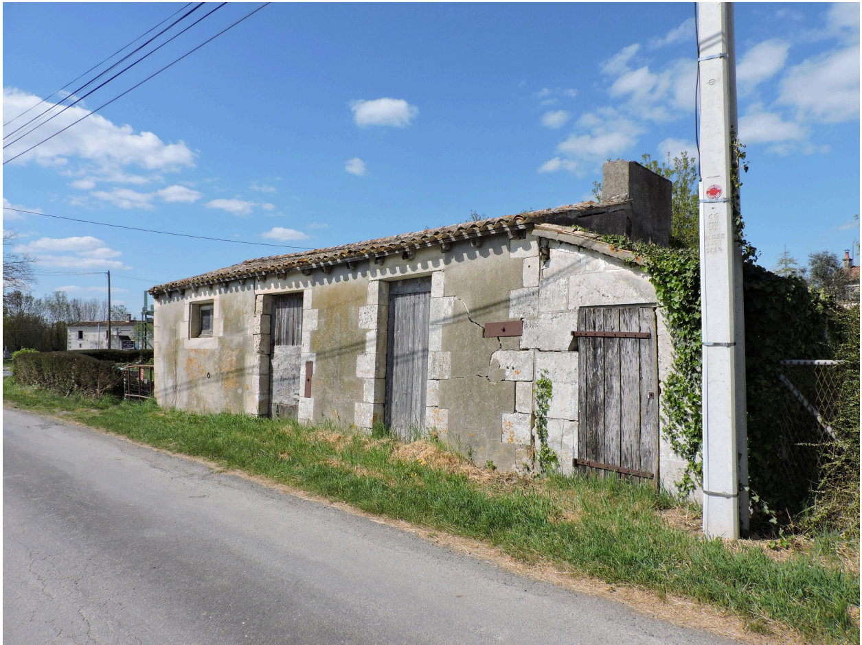
La dépendance située sur la rive nord du canal du Nouveau Béjou, vue depuis le sud-est.
