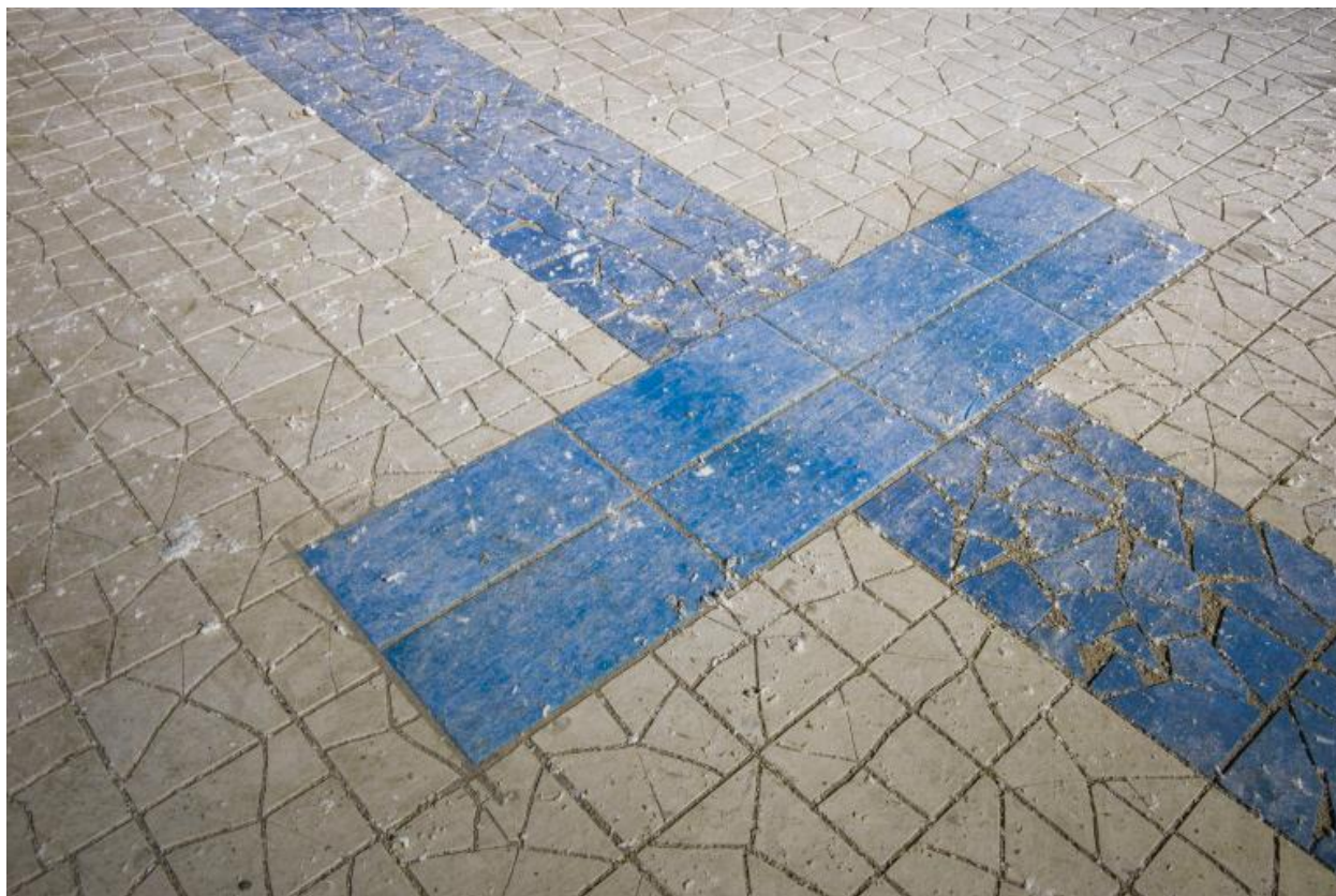
Détail du parement du sol du bassin de 25 mètres.
