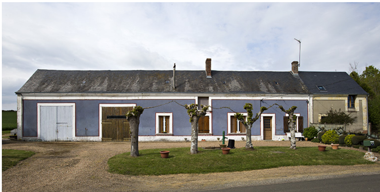
Vue générale depuis la route.
