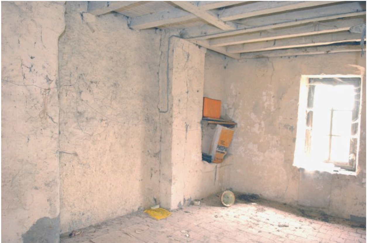
Aile en retour, premier étage : vestige d'une cheminée.
