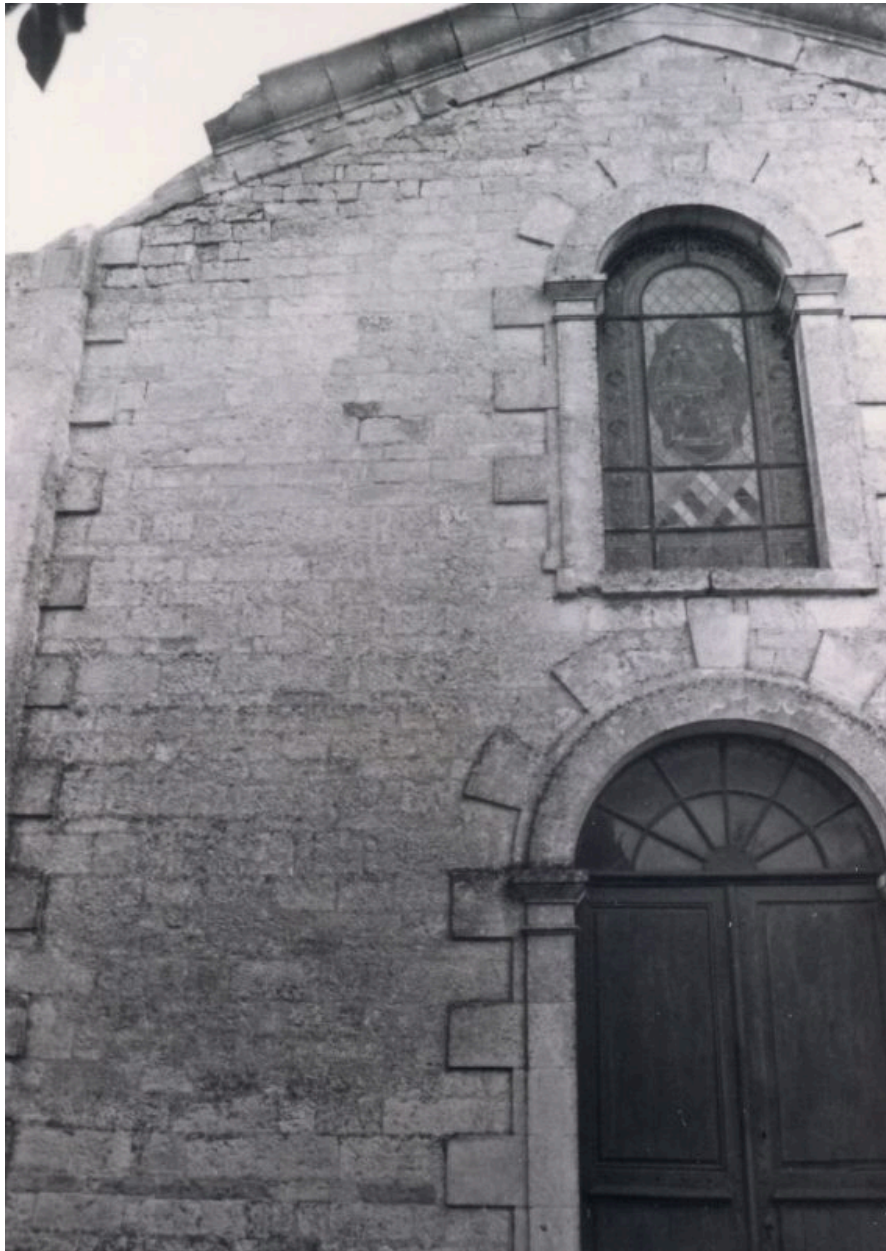
Détail de la façade nord-ouest de l'ancienne église vers 1970.
