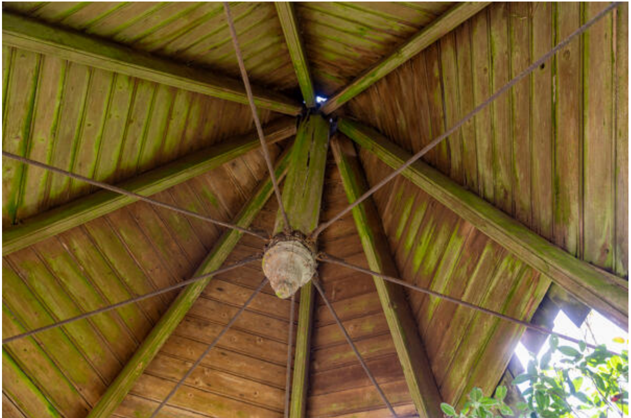
Un détail de la charpente du kiosque.
