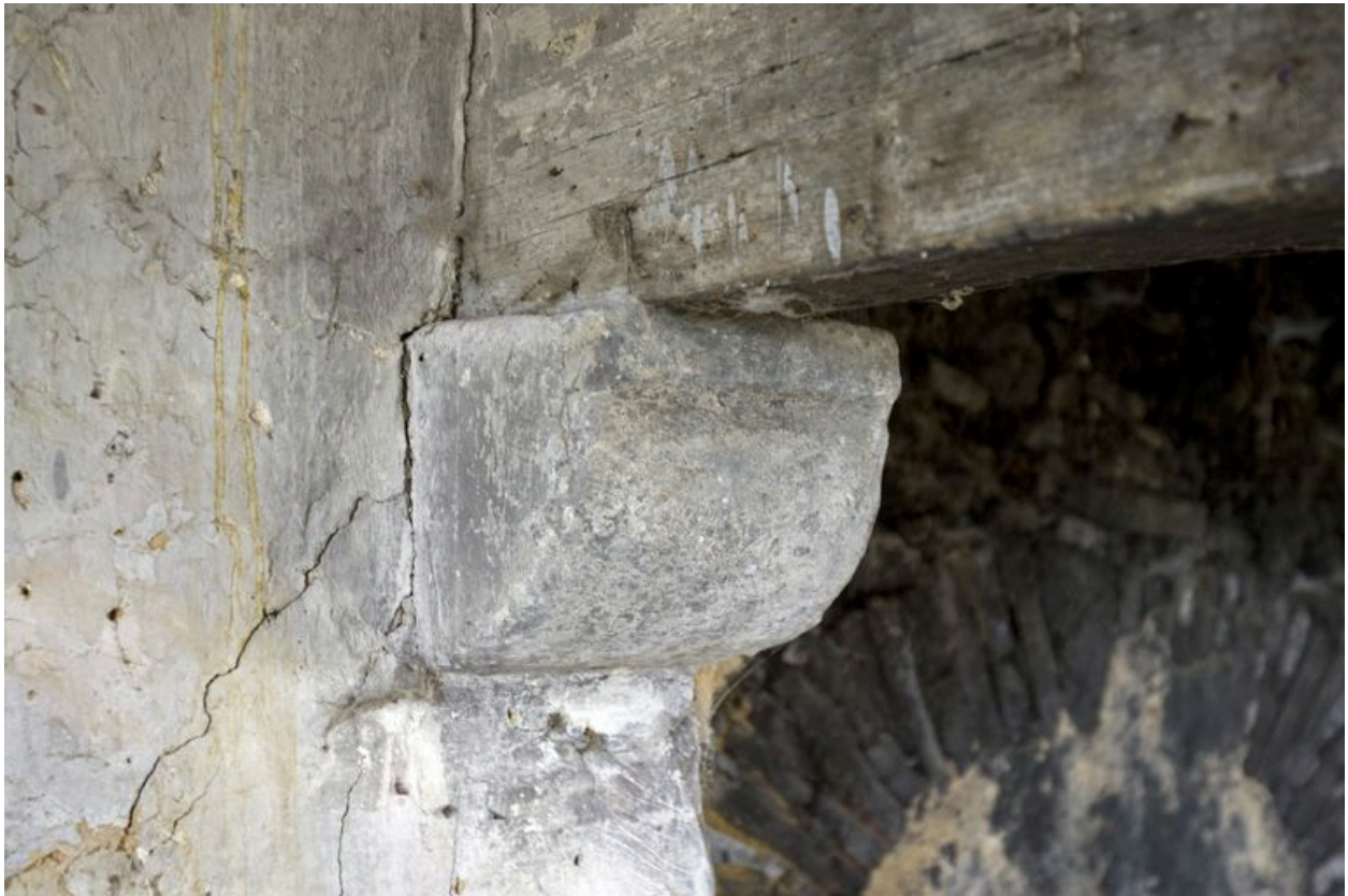
Détail de la cheminée du logis.
