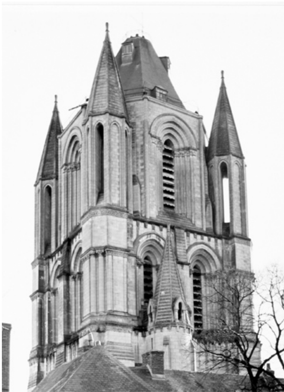
Tour-clocher dite tour Saint-Aubin, élévations extérieures ouest et sud : détail sur les parties hautes.
