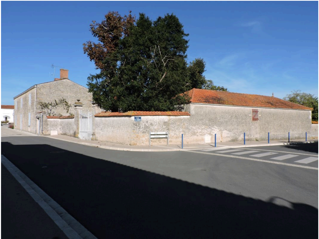
La propriété vue depuis le sud-ouest.
