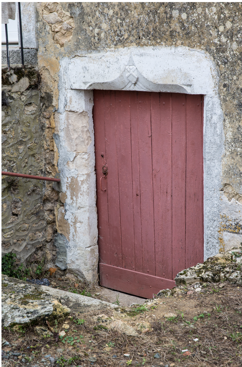
La porte de la cave avec linteau à accolade.
