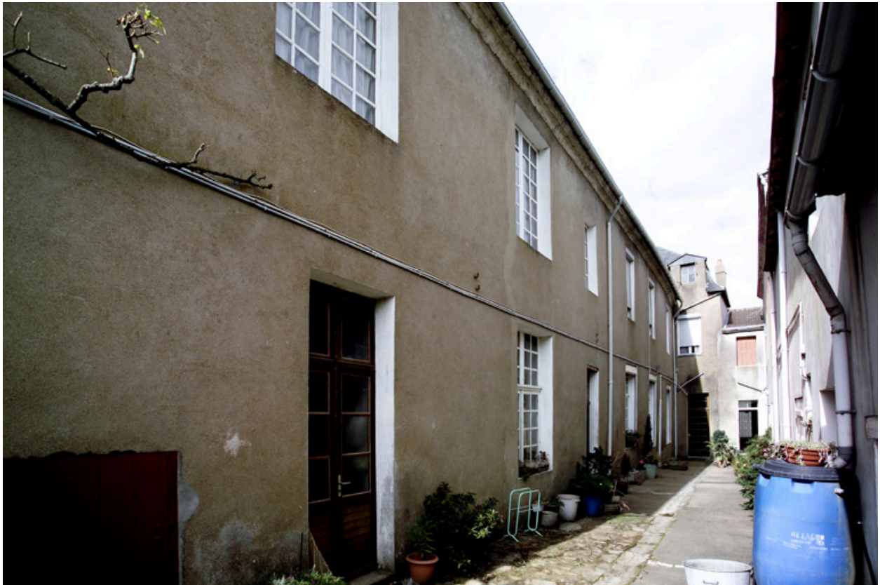
Les façades postérieures depuis la cour vers le quai.
