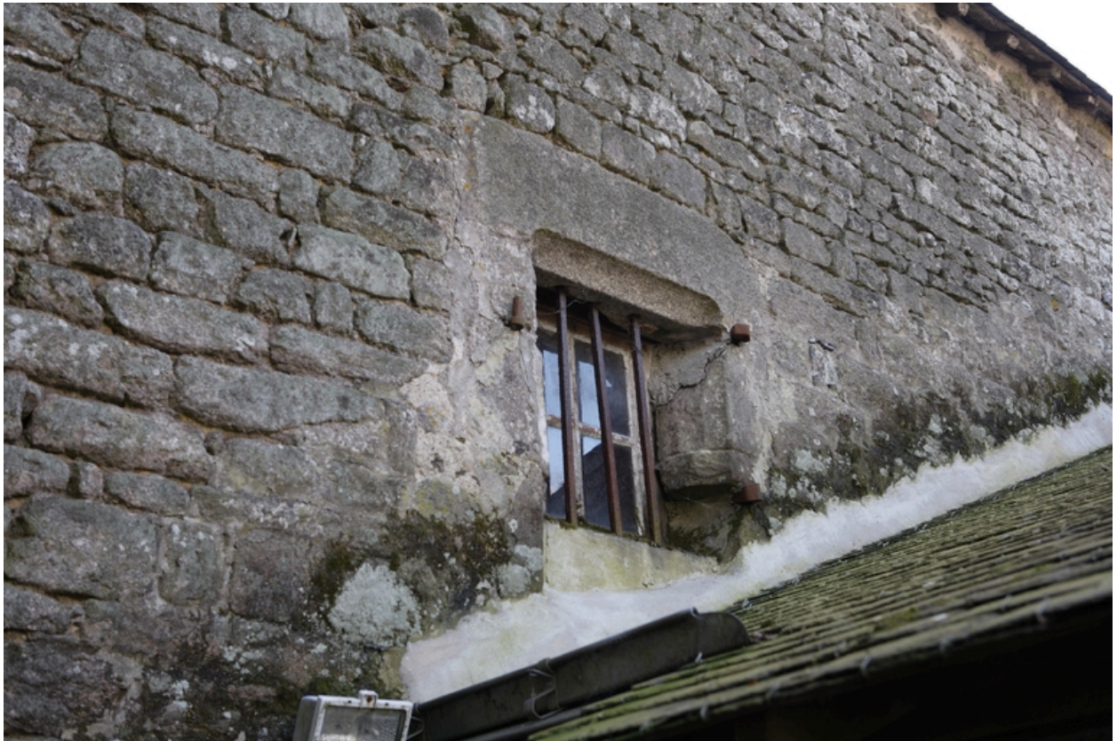
Logis. Aile nord. Mur gouttereau nord. Détail de la fenêtre de l'étage.
