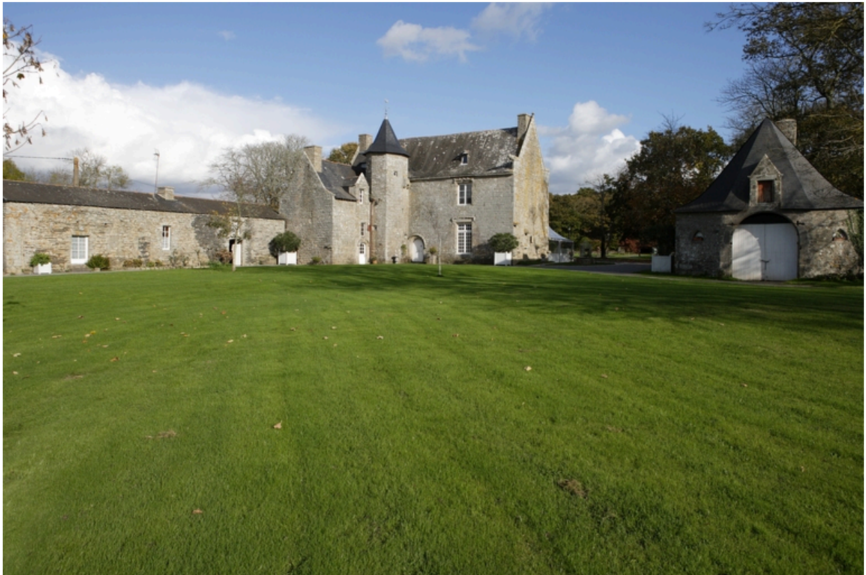
Logis. Vue d'ensemble depuis l'ouest.
