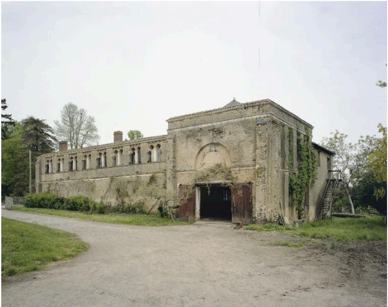
Bâtiment est, façade ouest (1984).
