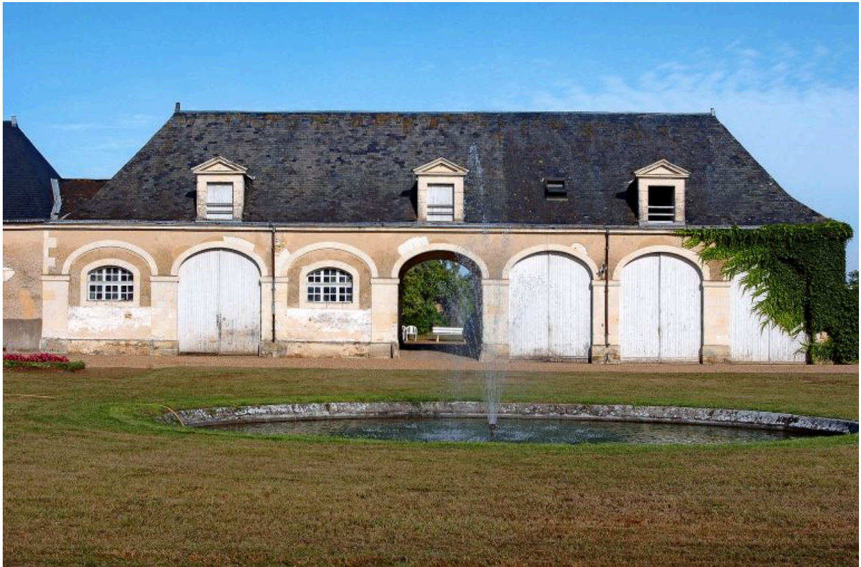
Bâtiment des remises.
