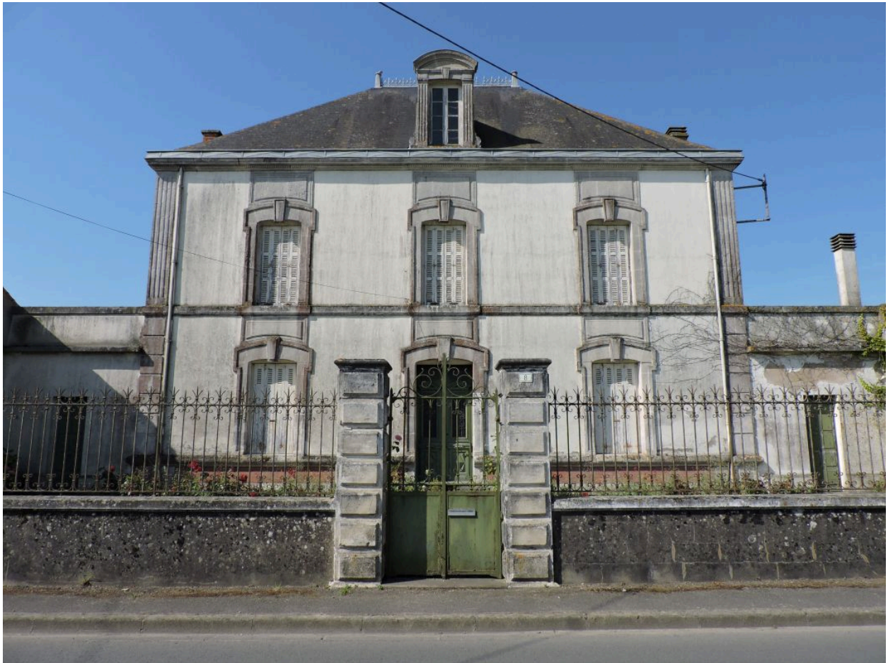
Vue d'ensemble de la façade.
